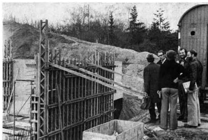
Das Belebungsbecken in der Einschalung vor dem Betonguß (2. von links Stadtdirektor Dr. Schumacher — 1. von rechts Beigeordneter Dr. Klewitz) Foto: W. Gewandtka
